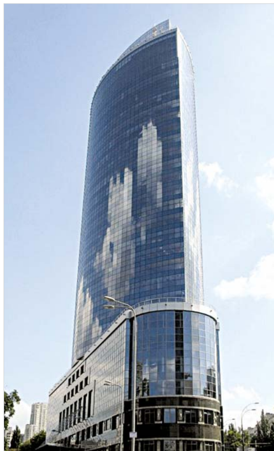
Внутрішні оздоблювальні роботи в Бізнес-центрі «Парус» (м. Київ)
